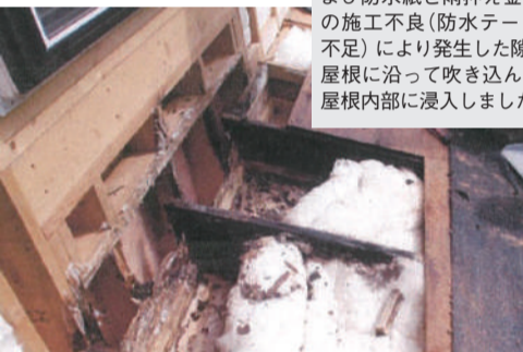
【写真1】「下屋根水上側取合い部」の雨漏り事故事例
