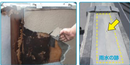
手すり壁天端の防水紙留め付けにステーブルを脳天打ちしています。笠木取付け後に継手部分より雨水が入り、防水紙上に雨水が溜まりステーブル部分から雨水の浸入が生じました。
