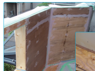
【写真】FRP防水の施工
