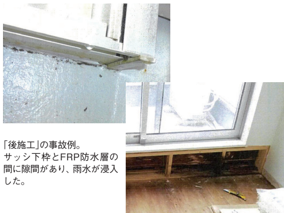
【写真1】サッシ下枠防水取合いからの雨漏り事故
